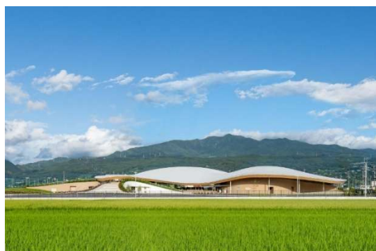
シェルターインクルーシブプレイス コパル 全景
