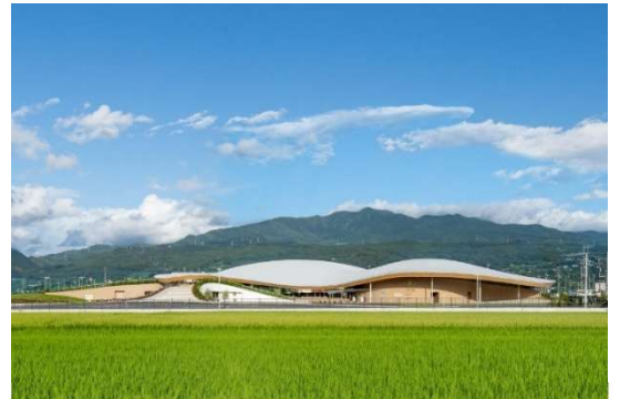
シェルターインクルーシブプレイス コパル 全景
